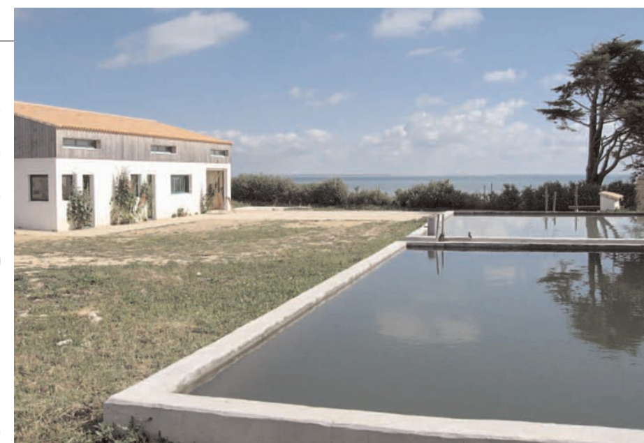
Ci-dessus: la ferme aquacole est composée de six bassins d'élevage d'une capacité annuelle d'une tonne d'oursins.
